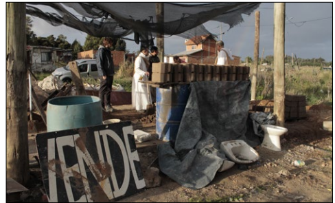
Figura 6. Bloquera “Joel” Barrio Nuevo Golf, en el aporte de bloques para la construcción del espacio comunitario. Fuente: Archivos propios.
