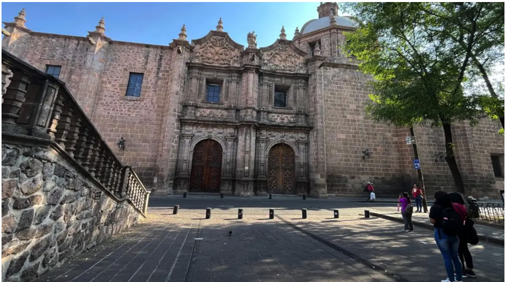
Fotografía 1. Vista frontal del templo de Santa Rosa de Lima desde el andador el Nigromante, límite oeste del Jardín de las Rosas, que separa el jardín del edificio de oficinas de tesorería de la Universidad Michoacana de San Nicolás de Hidalgo (UMSNH), Morelia. Fuente: Luna Monroy, 2024. [https://canterahoy.com/unico-templo-de-morelia-sin-torre-pero-con-un-campanario-santa-rosa-de-lima-y-sus-secretos/].
