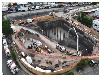
Fotografía durante la construcción del acceso a Carrillo.
