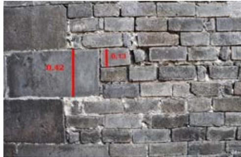
**Figura 8.** Detalle de la proporción 3:1 entre los dos tipos de sillares: prehispánicos y españoles. Fotografía realizada por el autor.
