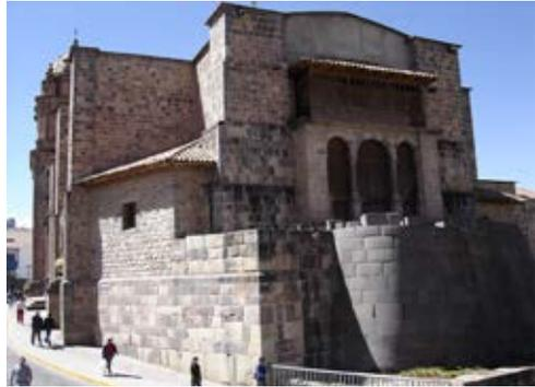
**Figura 15.** Templo del *Qorikancha*. Ábside del templo de Santo Domingo levantado sobre el muro curvo del recinto sagrado del templo del Sol. Destaca la capilla absidal tipo galería y balcón. Fotografía del propio autor.
