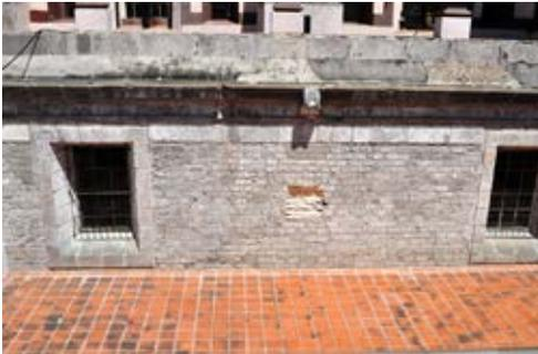
**Figura 7.** Muro sur de la catedral de Puebla donde se aprecian los dos tipos de sillares: prehispánicos y españoles. Fotografía realizada por el autor.
