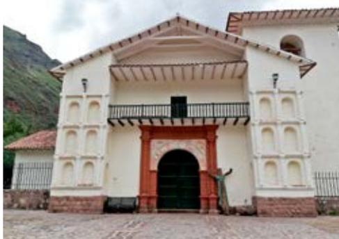
**Figura 33.** Capilla abierta o de indios. Santa María Magdalena de Taray. Estructura tipo balcón dispuesta entre las antas nichadas y protegida por un tejazoz, elementos que destacan la importancia del elemento dentro del conjunto arquitectónico. Fotografía del propio autor.
