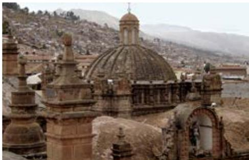
**Figura 17.** Cúpula de media naranja del Templo del Triunfo. Al demolerse la primitiva Catedral, se construye en el siglo xviii, sobre el antiguo sector del ábside, una cúpula sobre pechinas, que protegía un tabernáculo expuesto sobre el atrio, señalando el lugar de la Descensión de María. Hoy forma parte de las naves del Templo del Triunfo (también conocido como la Matriz), estructuras del siglo xviii. Fotografía del propio autor.
