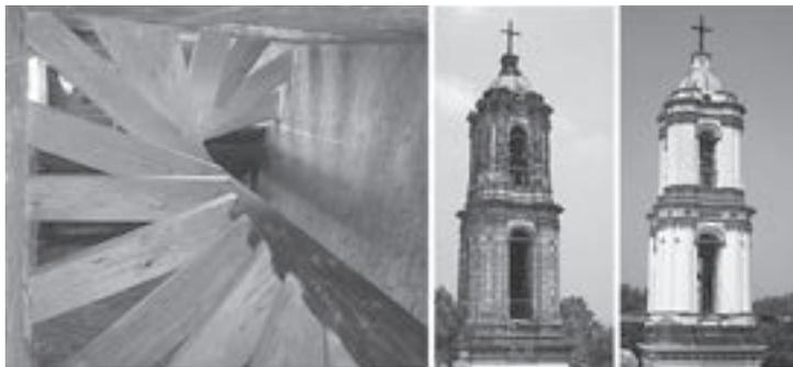
Figura 18. Escalera restaurada de la torre campanario y campanario antes y después de los trabajos de restauración efectuados en 2010.
