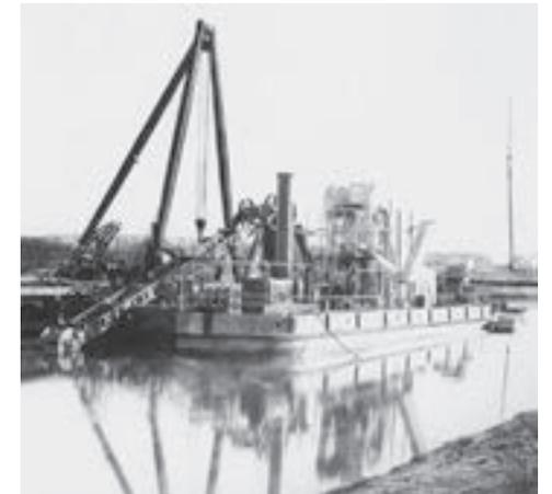
Figura 3. "Draga y buque La María en el canal del oeste, tomado del terraplén del dique particular" 18 meses después de emplazadas las obras. Tomás Bradley, Marzo de 1895. (Rivelli, 2007:82).
