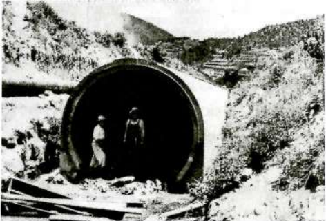
Una sección del acueducto de concreto en Atarasquillo, Méx.
