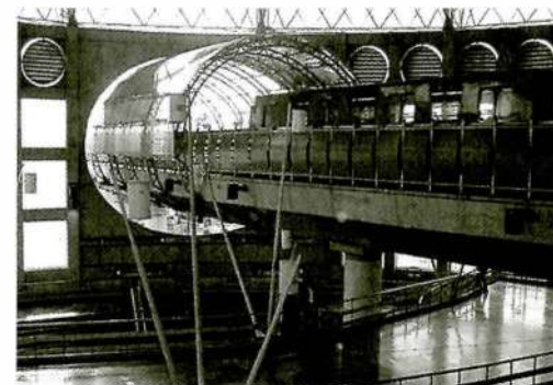
Estación del metro San Lázaro interior.
