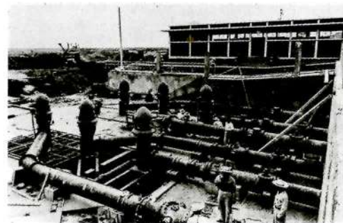
Bombas para elevar el agua al Acueducto. Obras para la provisión de agua potable. 1951.
