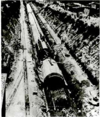
Tramo del acueducto de concreto antes del portal de entrada del Túnel de Atarasquillo-Dos Ríos. Obras para la provisión de agua potable, 1951
