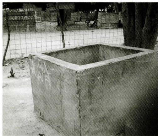
Fotografía 4: Mecanismo de almacenamiento de agua: tanque artesanal.
