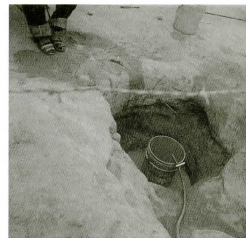
Fotografía 11: Mecanismos de abastecimiento de agua: pozo artesanal.
