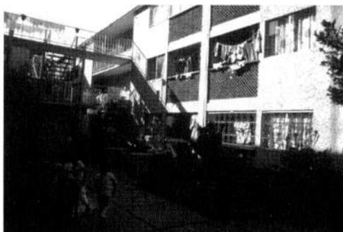
Isabel la Católica 137, vivienda nueva construida con financiamiento de ONG
