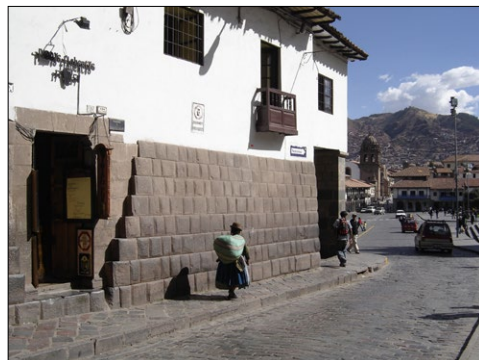
Figura 11. Fragmento de los muros de piedra andesita del conjunto urbano de Hatunkancha .
