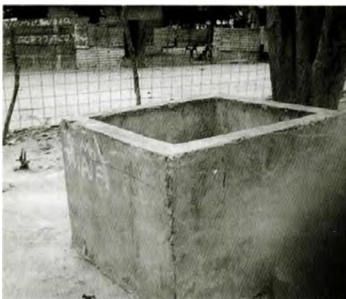
Fotografía 4: Mecanismo de almacenamiento de agua: tanque artesanal.
