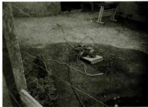
Fotografía 13: Mekanismos de abastecimiento de agua: bomba de succión de agua secundaria.
